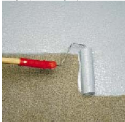
Нанесение МАРЕСОАТ I24 с помощью валика.
