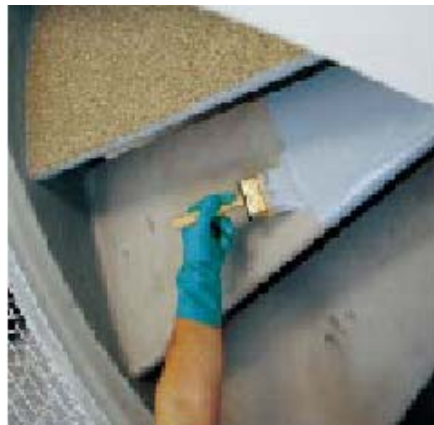
Нанесение первого грунтовочного слоя МАРЕСОАТ I24 на бетон.
