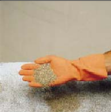
Нанесение сухого песка на свежий слой МАРЕСОАТ I24 .
